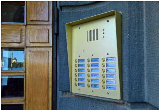
Ovipuhelinjärjestelmän kutsutaulu, eloksoitu alumiini, värisävy "dark gold- messinki". Tuotemerkki: Eltas-Elkesan. Asiakas: As Oy Pohjoisranta 8, Helsinki.
