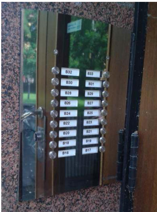
Summerijärjestelmän kutsutaulu, kiillotettu jaloteräs. Tuotemerkki: Elkesan. Asiakas: As Oy Tukholmankatu 13, Helsinki.
